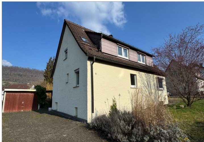
Ansicht mit Garage
