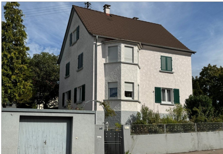
Ansicht mit Garage
